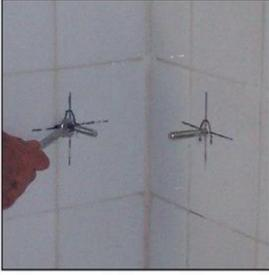
**1** Verilen ölçülerde yan duvarlara pis su gideri ve sıcak-soğuk su merkezlerinin alt yapıları hazırlanır. Köşe lavabo delik yerleri duvara markalanarak dübel boyu kadar delinir ve dübeller yerleştirilir. Trifon vidalar dübellelere yerleştirilir.
